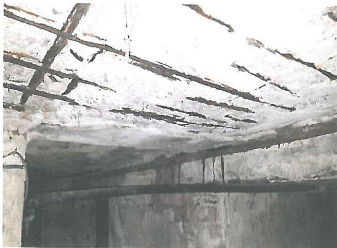
Foto 3 si 4 – armatura vizibila si corodata subsol 2 la stalp si plansee
