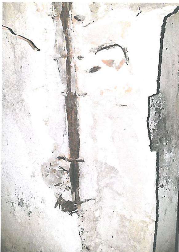
Foto 3 si 4 – armatura vizibila si corodata subsol 2 la stalp si plansee
