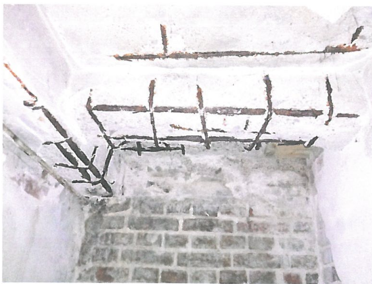
Foto 1 si 2 – armatura vizibila si corodata subsol 1 la grinzi si plansee
